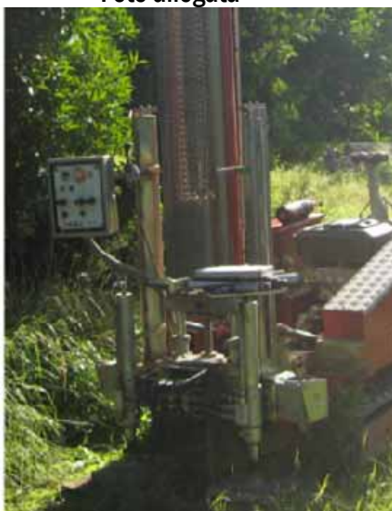
Foto 1 – Sondaggio penetrometrico dinamico superpesante n. 1 DPSH
